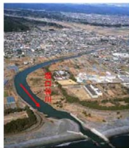
坂口谷川河口部の様子(平成22年2月撮影)
