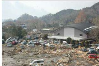
野蒜小学校(体育館)
