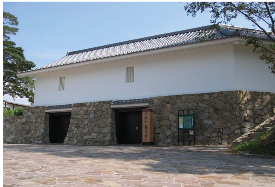
報民倉(拠点防災備蓄倉庫)
