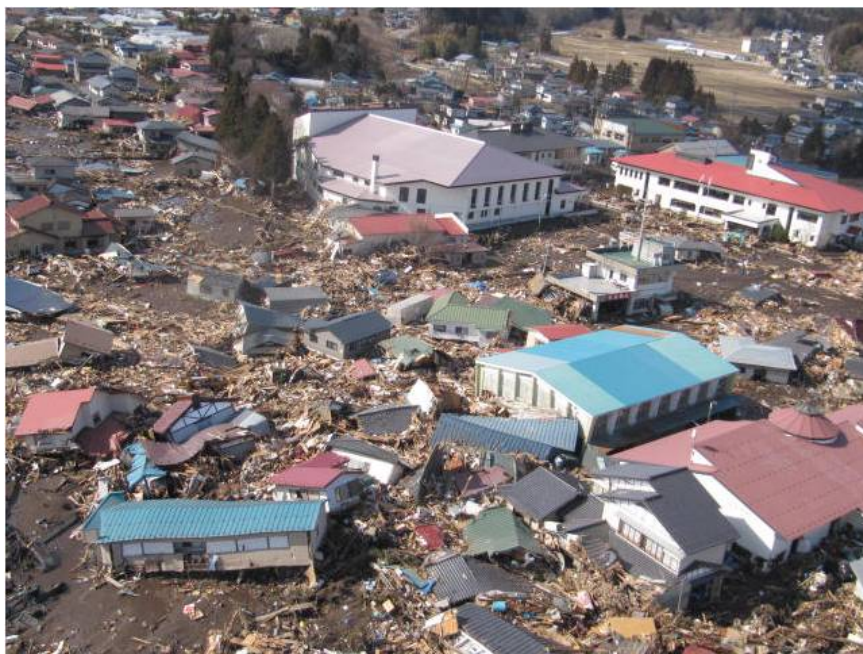
津波発生直後の状況(岩手県九戸郡野田村)
