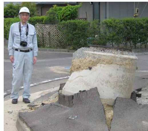
地盤液状化によるマンホールの浮き上がり (宮城県白石市緑が丘付近) ※岐阜大学地震工学研究室提供
