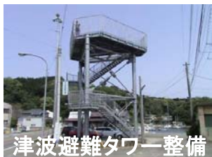
避難施設の整備
