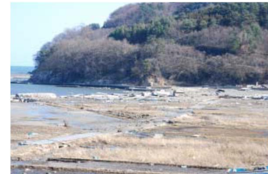
破壊された吉浜海岸防潮堤
