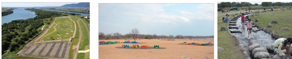
桜堤サブセンター(高水敷エリア)
