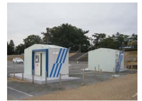
循環式トイレ
