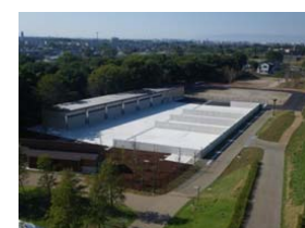
フラワーパーク江南の堆肥化施設
