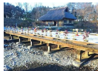
管理施設(橋梁)
