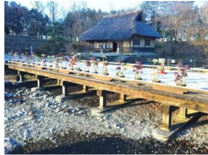
管理施設(橋梁)
