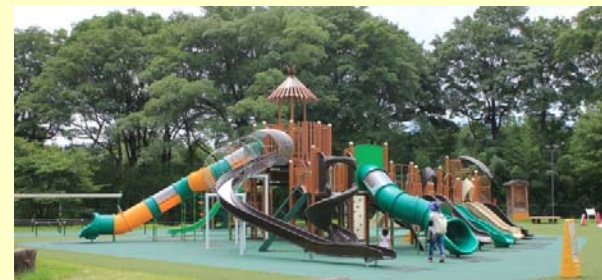
老朽化した遊具の再整備(138タワーパーク)
