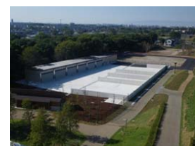
フラワーパーク江南の堆肥化施設
