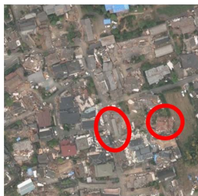
<平成28年熊本地震 被災後（2016年4月16日撮影）>
