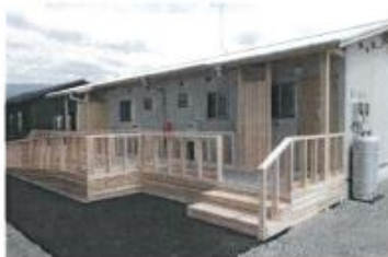
■玄関スロープや玄関の木の袖壁
