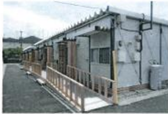
スロープが設置された住宅
