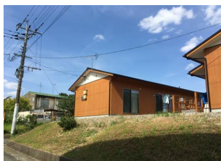
■木造仮設住宅
