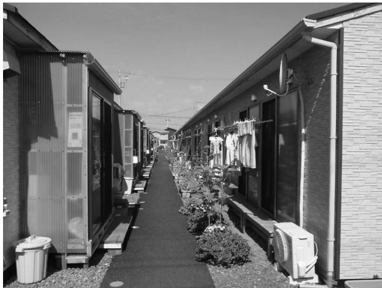
宮城県名取市の建設型応急住宅
