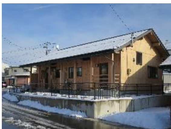
■既存応急仮設住宅を再利用して整備された復興公営住宅
