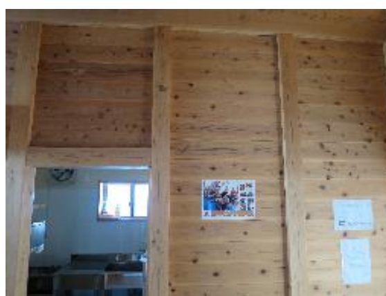
■再利用された柱や落とし込み板
