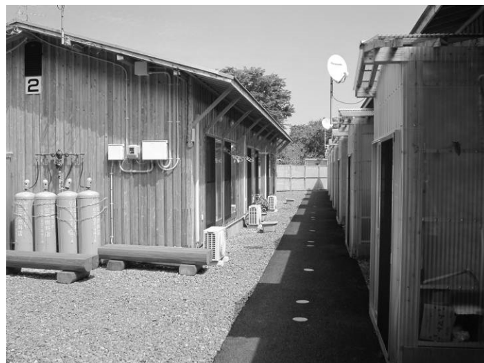
岩手県宮古市の建設型応急住宅
