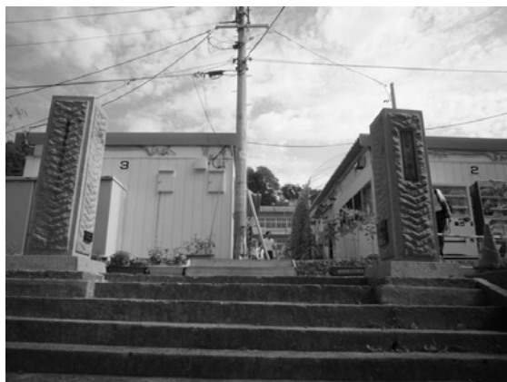
岩手県宮古市の建設型応急住宅
