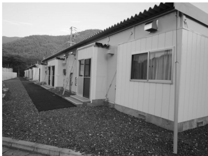
岩手県宮古市の建設型応急住宅
