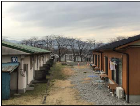
■既存公営住宅(左)と木造仮設住宅(右)
