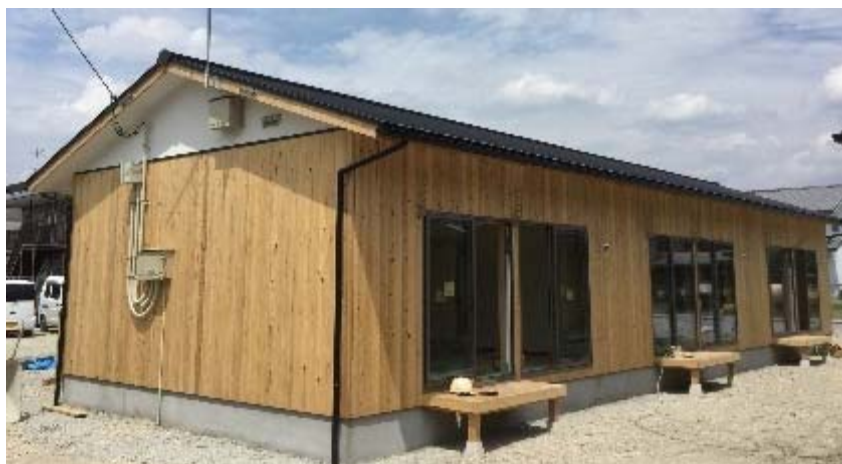
木造仮設住宅の例
