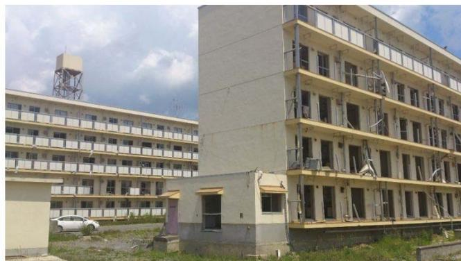
※) 前面の建物と背面の建物ではベランダの破損状態に違いが生じている
