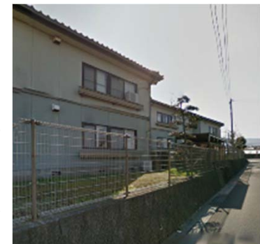
軽量鉄骨プレハブ造による災害公営住宅の早期供給
