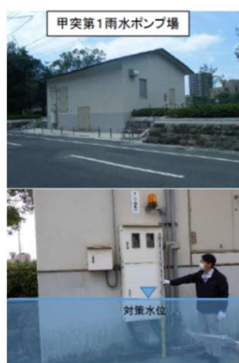
図 ポンプ場の耐水化【鹿児島県鹿児島市】 (出典:甲突川水系流域治水プロジェクト)
