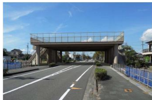
写真 道路空間を活用した津波避難タワー（静岡県吉田町）
