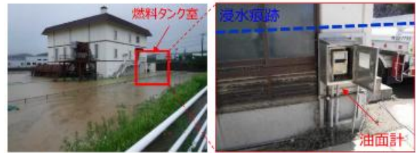
施設内への浸水はなかったものの、屋外に設置していた燃料移送ポンプの油面計が浸水により停止し、運転ができなかった。
