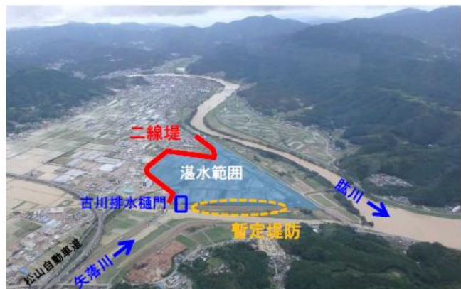
写真 二線堤の整備事例 （愛媛県大洲市 脇川水系脇川・矢落川） （出典：国土交通省気候変動を踏まえた水災害対策小委員会第3回資料 3「ハザード制御を中心としたハード対策について」令和2年3月）
