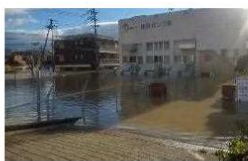
ポンプ場浸水状況
