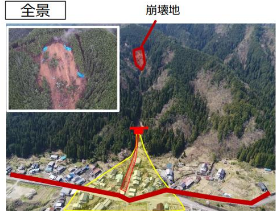
全景 崩壊地 保全対象 人家9戸、主要地方道 白鳥板取線
