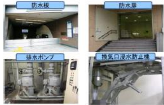
図 地下への浸水防止対策例
