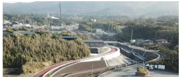
写真 大金沢流域隣接町道整備事業（東京都大島町）
