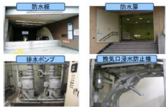
図 地下への浸水防止対策例
