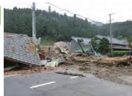
紀伊半島大水害 (平成23年)に よる土砂災害 (三重県津市)
