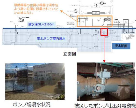
図 令和元年東日本台風時のポンプ場浸水（郡山市） （出典：第1回気候変動を踏まえた下水道による都市浸水対策に関する検討会資料）
