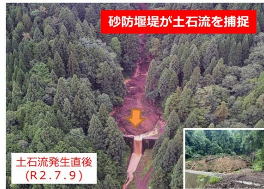
写真 ハード対策の例（砂防堰堤）
