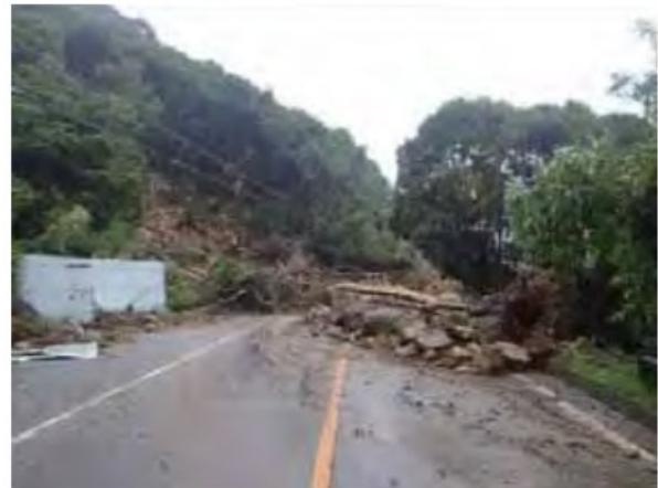
写真 平成23年紀伊半島大水害時の鵜殿熊野線の法面崩壊（三重県紀宝町）
