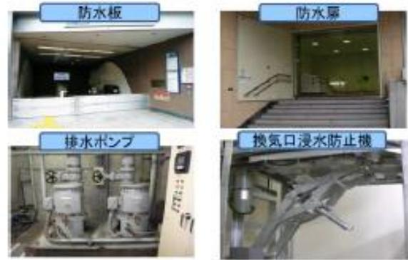
図 地下への浸水防止対策例
