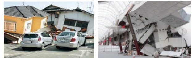
写真 住宅や店舗の倒壊（熊本地震 熊本市） （出典：熊本市消防局「平成28年熊本地震 熊本市消防局活動記録誌」平成30年3月）
