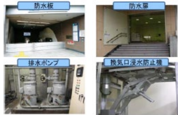
図 地下への浸水防止対策例 (出典：国土交通省・農林水産省「流域治水施策集 水害対策編」令和5年3月)
