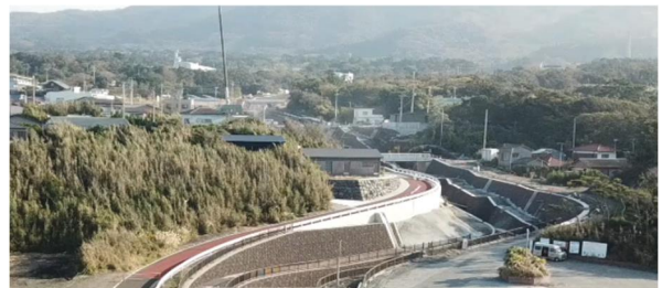
写真 大金沢流域隣接町道整備事業（東京都大島町） （出典：大島町「平成25年伊豆大島土砂災害 後期復興事業住民説明会資料 元町地区の復興まちづくり事業」令和2年12月）
