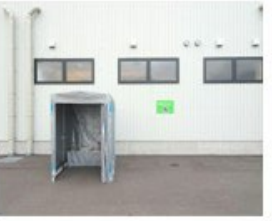
【マンホールトイレ】
