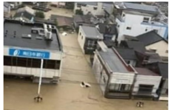
写真 令和2年7月豪雨の浸水の状況 （出典：国土交通省HP「総力戦で挑む防災・減災プロジェクト」【第2弾】）
