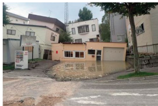
液状化被害の様子 （北海道胆振東部地震 札幌市清田区） （出典：内閣府「令和元年度 防災白書」）
