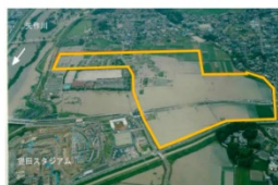
中央公園第二期整備予定地 浸水状況 （平成11年6月30日）
