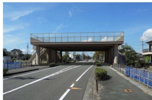
写真 道路空間を活用した津波避難タワー（静岡県吉田町）
