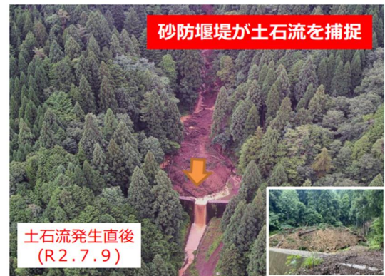
写真 ハード対策の例（砂防堰堤） （岐阜県郡上市大和町島 令和2年7月の豪雨による土砂災害） （出典：岐阜県砂防部ホームページ 砂防事業「R2 事業効果事例」）
