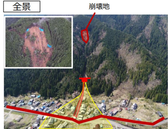
保全対象 人家9戸、主要地方道 白鳥板取線
