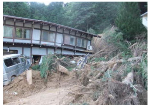
写真 平成26年8月豪雨による岐阜県飛騨地方の土砂災害（岐阜県高山市） (出典：岐阜県ホームページ「土砂災害・過去の災害事例」)
