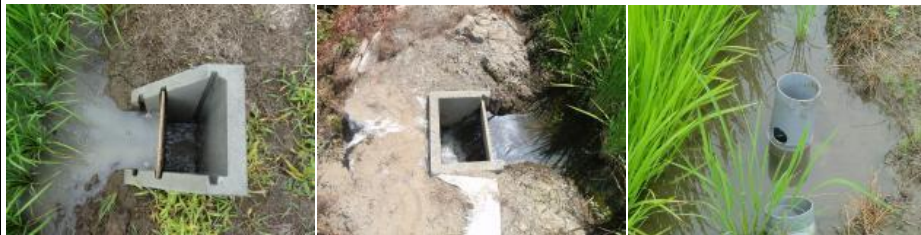
分離型田んぼダムます 片浮かせ型田んぼダム フリードレタイプ
