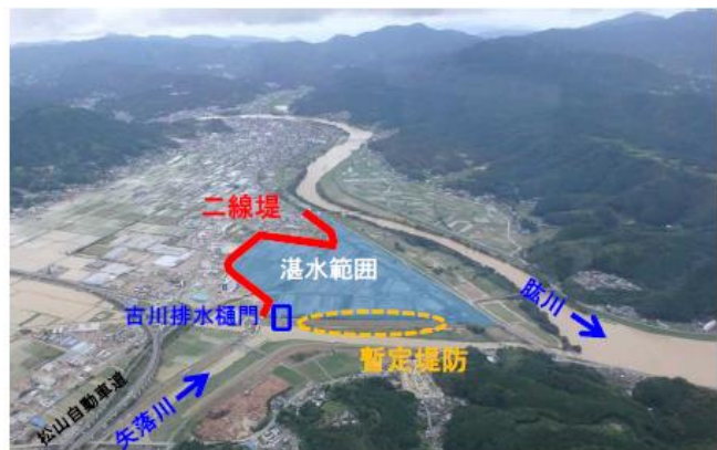
写真 二線堤の整備事例 (愛媛県大洲市 肱川水系肱川・矢落川) (出典：国土交通省気候変動を踏まえた水災害対策小委員会第3回資料 3「ハザード制御を中心としたハード対策について」令和2年3月)
