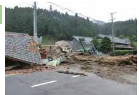
紀伊半島大水害 （平成23年）に よる土砂災害 （三重県津市）
