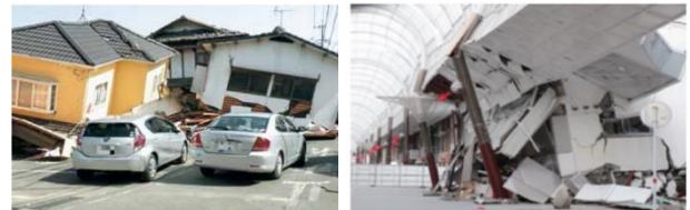
写真 住宅や店舗の倒壊（熊本地震 熊本市） (出典：写真左 熊本市消防局「平成28年熊本地震 熊本市消防局活動記録誌」平成30年3月 写真右 熊本市「平成28年熊本地震 熊本市震災記録誌」平成30年3月)
