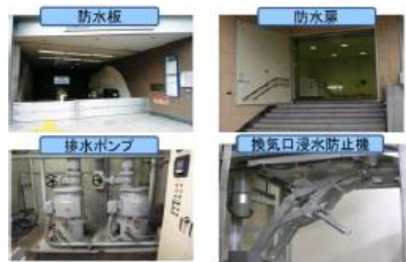
図 地下への浸水防止対策例 (出典：国土交通省・農林水産省「流域治水施策集 水害対策編」令和4年12月)
