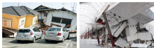
写真 住宅や店舗の倒壊（熊本地震 熊本市） （出典：写真左 熊本市消防局「平成28年熊本地震 熊本市消防局活動記録誌」平成30年3月 写真右 熊本市「平成28年熊本地震 熊本市震災記録誌」平成30年3月）
