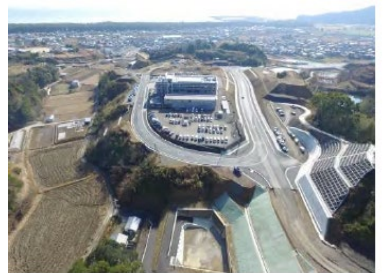
写真 庁舎の高台移転（高知県黒潮町） （出典：国土交通省四国地方整備局「災害に強いまちづくり計画（改定案）地域モデル：黒潮町」）平成30年3月
