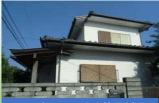
Aランク：そのまま使用が可能な状態。
