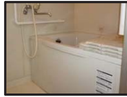
バリアフリー工事＜浴槽交換・手すりの設置＞
