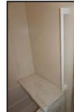
バリアフリー工事＜浴槽交換・手すりの設置＞
