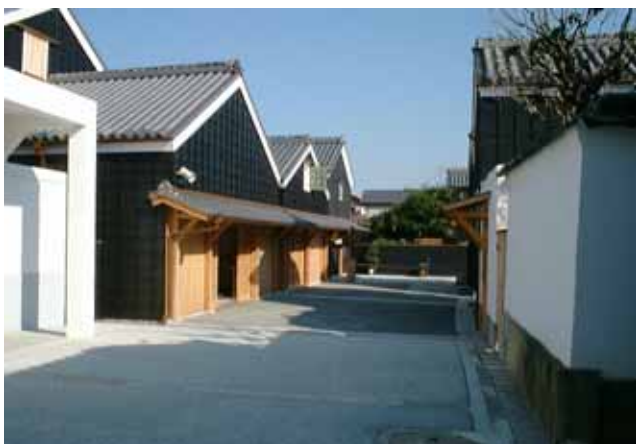
伊勢河崎商人館 ：河崎まちなみ館（中央：展示館） ：河崎角吾座（奥：イベント館）
