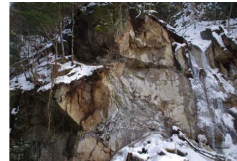
矢作川上流 喉の瀧付近(崩落箇所)
