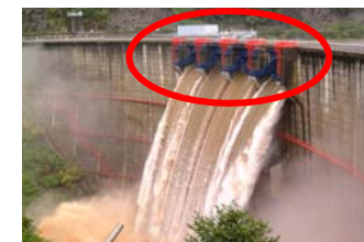
非常用洪水吐きからの放流
