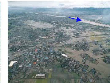
鹿乗川沿川(岡崎市)の浸水状況
