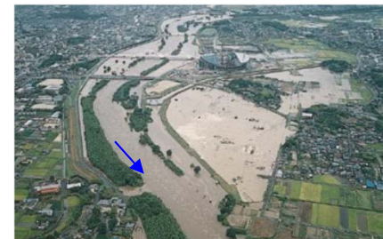
豊田市街地付近の越水氾濫状況
