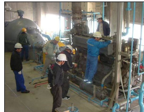
排水機場の保守点検状況
