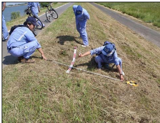
堤防等の点検状況
