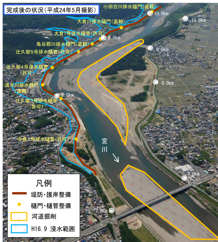
宮川床上浸水対策特別緊急事業箇所
