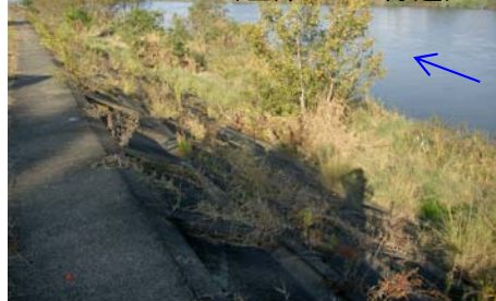
【整備前】河道掘削・樹木伐開（左岸11.0k付近）
