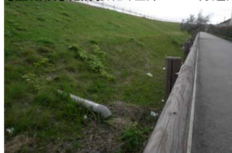
【整備前】堤防強化（左岸20.2k付近）
