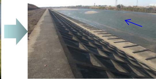
【整備後】河道掘削・樹木伐開（左岸11.0k付近）
