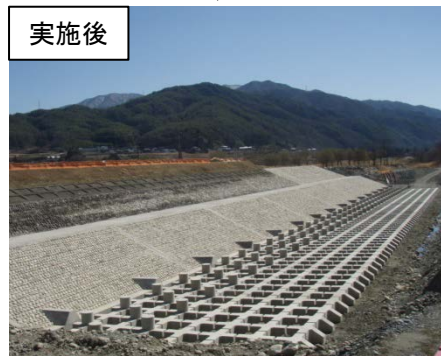
急流対策実施状況(H25年度実施)
