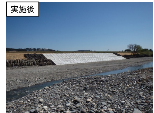
扇頂部対策実施状況(H26年度実施)
