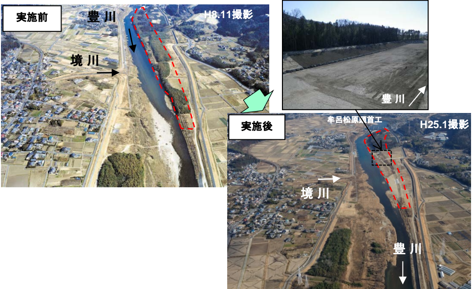
河道掘削状況 (H26年度完成予定)
