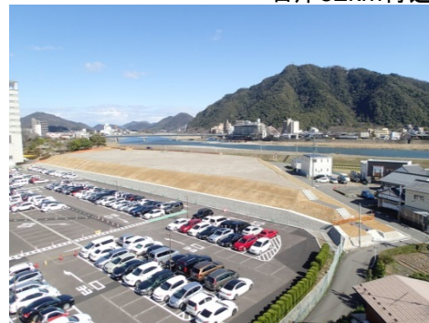
盛土造成状況（早田地区） （H25年度整備中）
