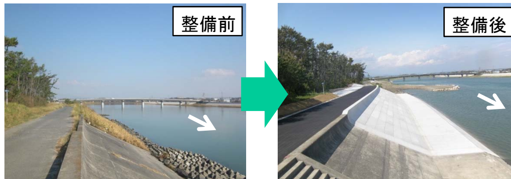
高潮堤防整備状況(菊川右岸0.5k付近)
