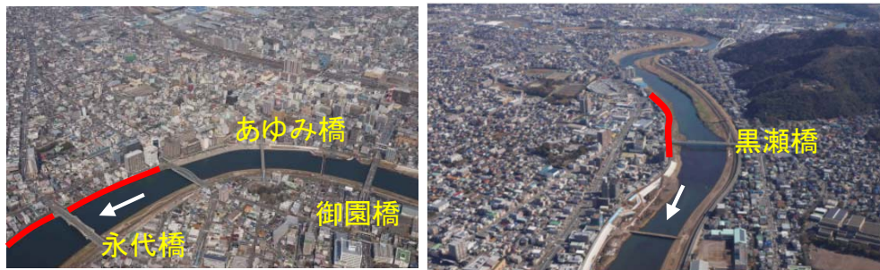
しもがわら 下河原地区の堤防整備
