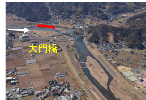
かみしま 神島地区堤防整備
