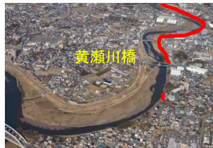
きせがわ 黄瀬川地区の堤防整備
