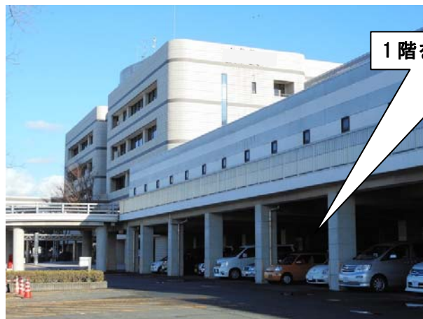
水道局庁舎のかさ上げ例
