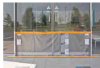
▲水害対策の止水シート設置
