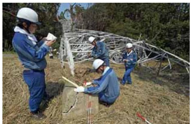
写真13.3.4 倒れた鉄塔の基礎部分の調査
