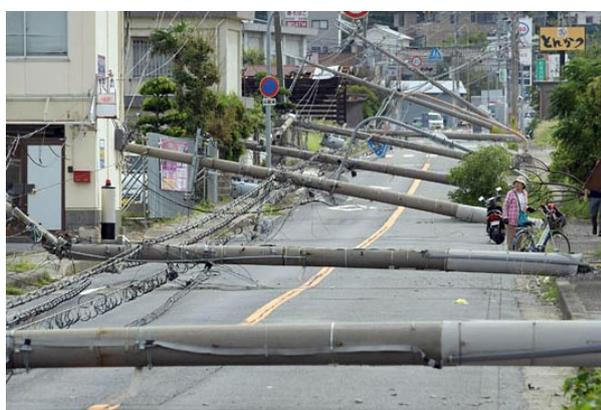
写真13.3.1 折損被害のあった電柱
