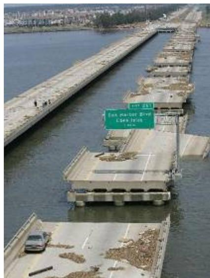
写真12.3.2 ハリケーンにより一部分断された高速道路の橋梁
