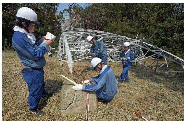
写真13.3.4 倒れた鉄塔の基礎部分の調査
