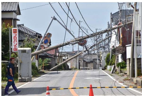
写真13.3.3 折損被害のあった電柱
