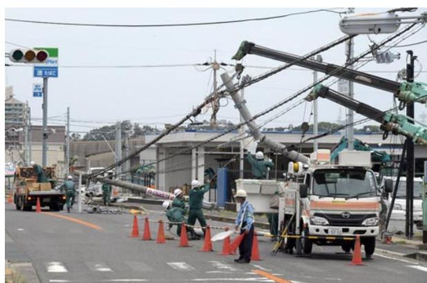
写真13.3.2 折損した電柱の復旧作業
