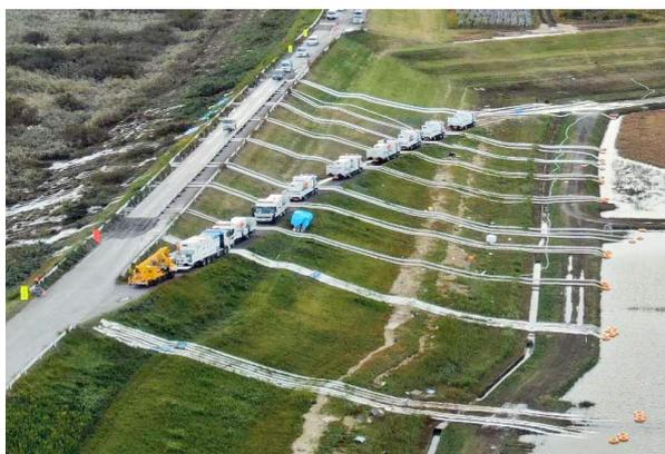
写真11.3.3 排水ポンプ車稼働状況
