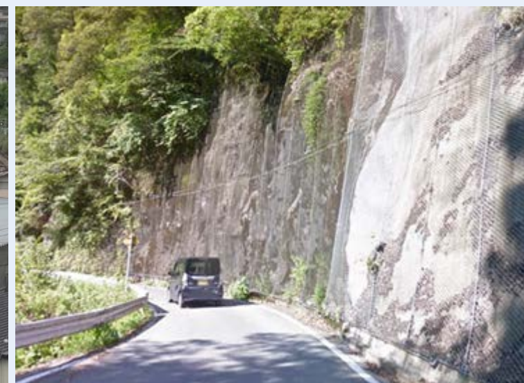
道路状況 幅員が狭小
