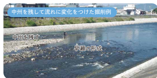
河床地形の平行移動（スライドダウン）や中州、寄州を残すこと等により流路に変化をもたせることで瀬淵が形成された
