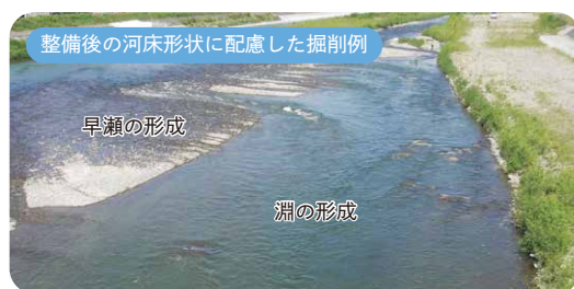
河床地形の平行移動（スライドダウン）や中州、寄州を残すこと等により流路に変化をもたせることで瀬淵が形成された
