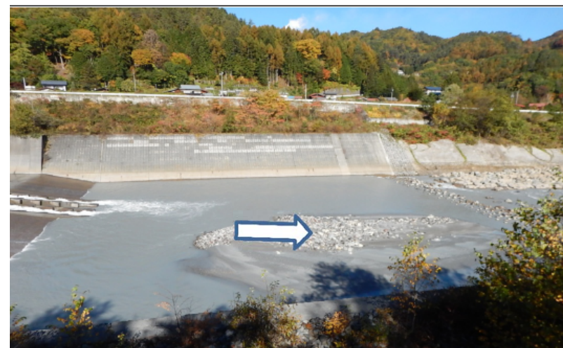
2号貯砂ダム 10/29 着手前
