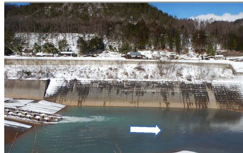
2号貯砂ダム 1/26 土砂撤去完了
