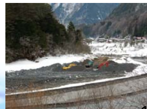
堆積土砂撤去状況
