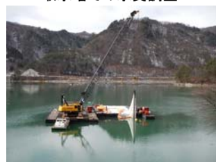
汚濁防止フェンス設置状況
