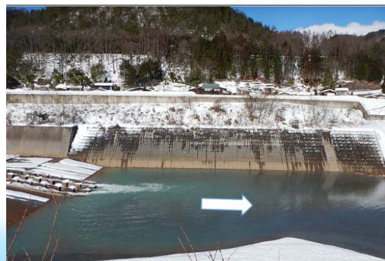
2号貯砂ダム 1/26 土砂撤去完了
