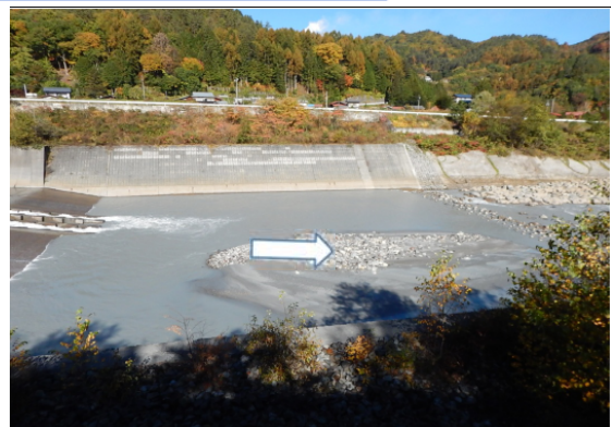
2号貯砂ダム 10/29 着手前
