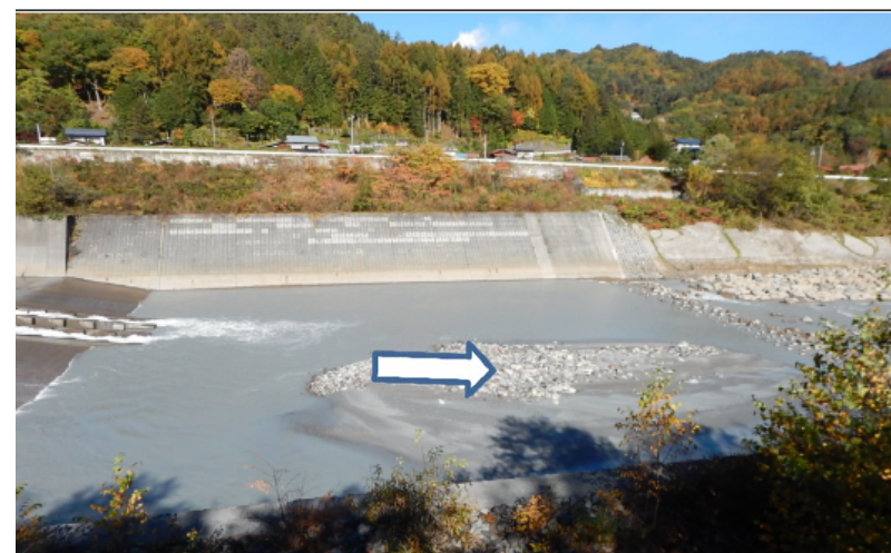
2号貯砂ダム 10/29 着手前
