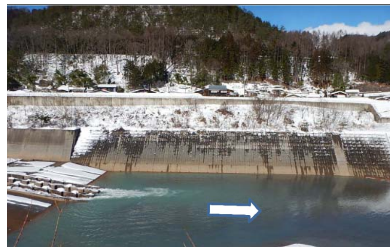
2号貯砂ダム 1/26 土砂撤去完了
