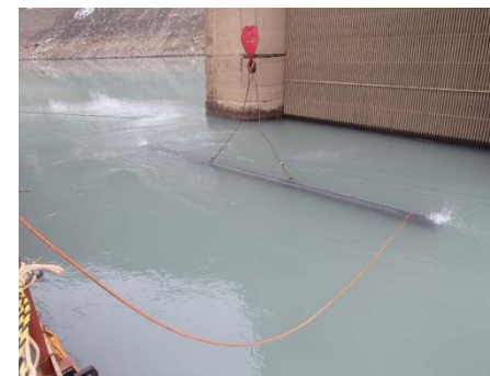
角落しの施工状況
