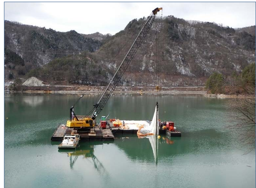
汚濁防止膜設置工事の状況
