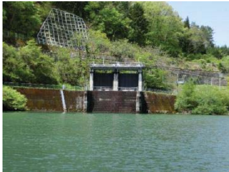
三尾発電所放水口正面写真
