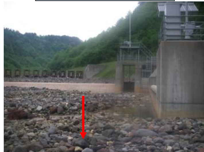
濁沢川えん堤(下流より撮影)
