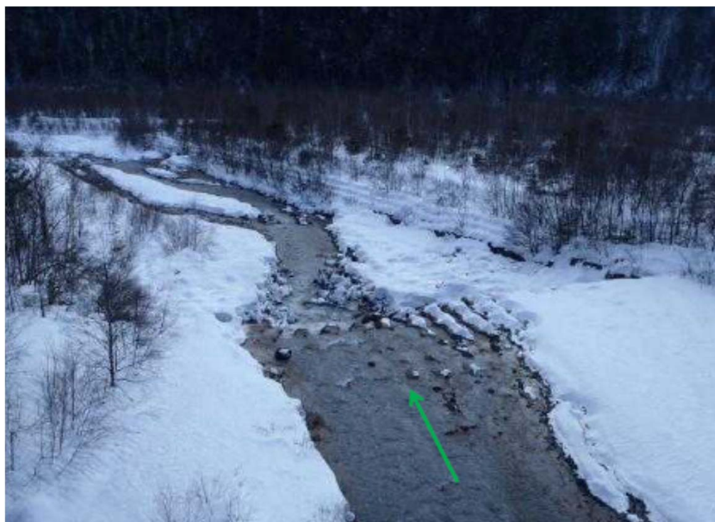
濁沢川 濁沢橋下流
