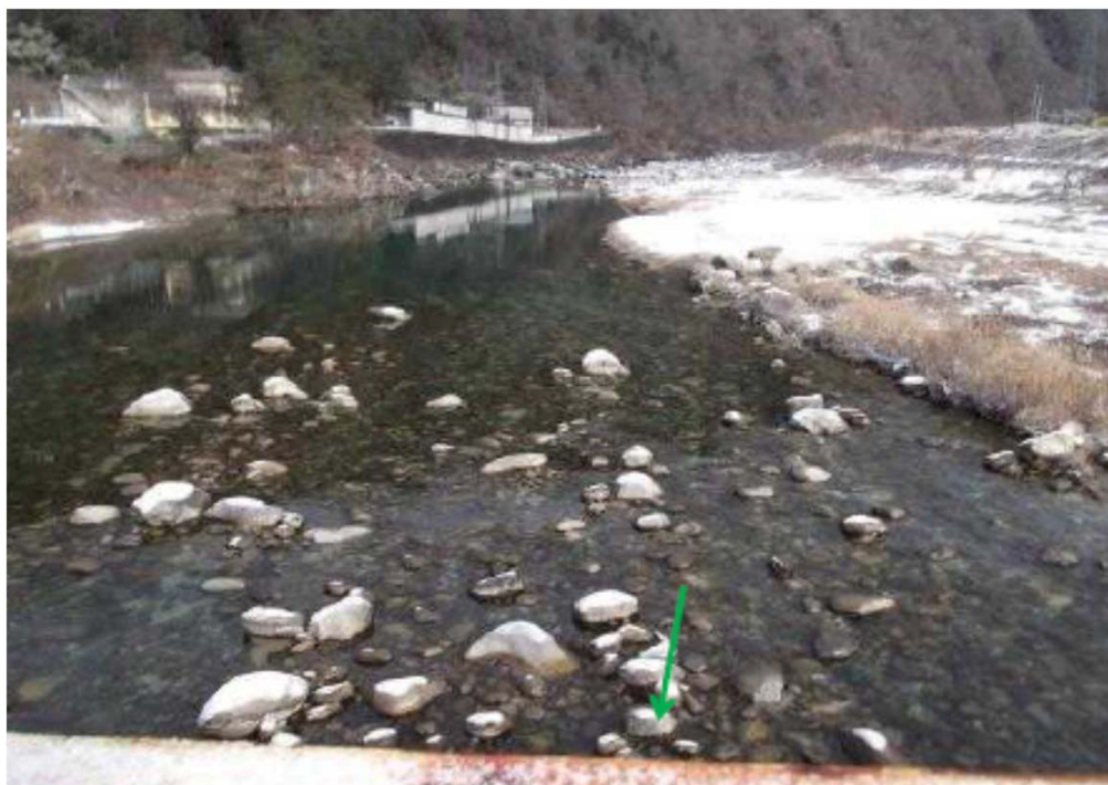
木曽川 殿橋上流
