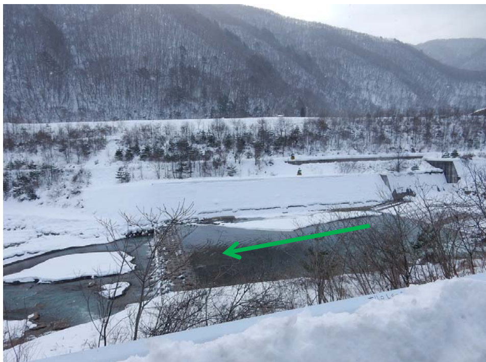
牧尾ダム 上流端
