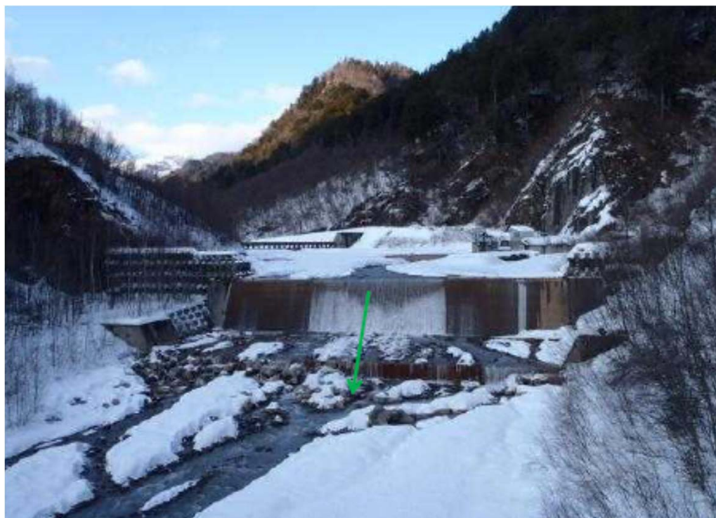
濁沢川 濁沢橋上流
