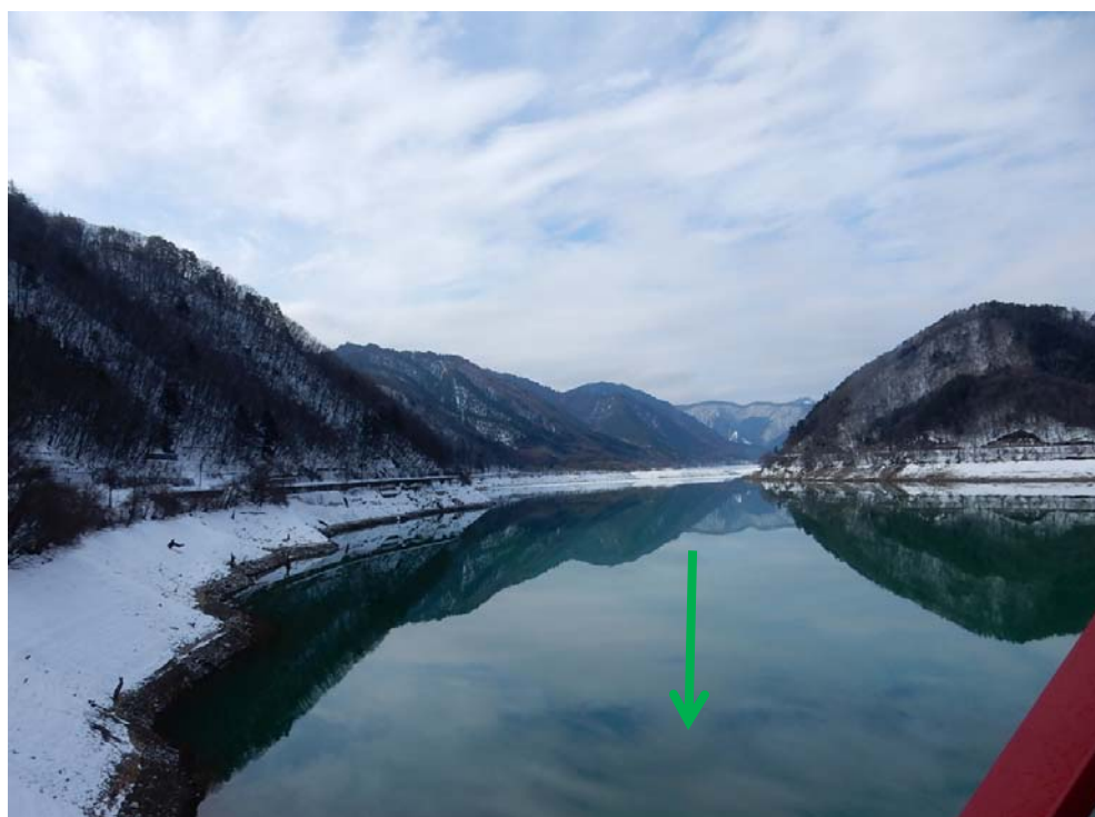
牧尾ダム 取水塔から上流
