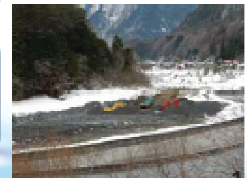
堆積土砂撤去状況
