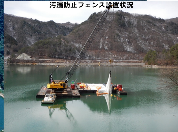
取水口前面にフェンスを設置し、火山噴出物の流出抑制を図る。
